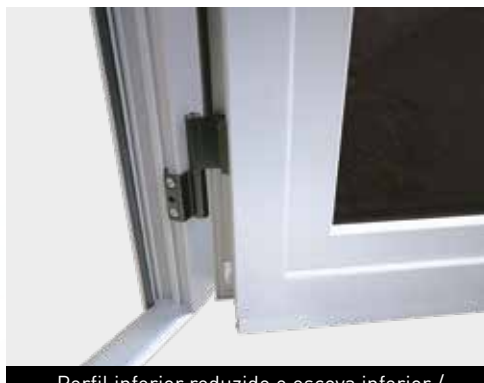
Perfil inferior reduzido e escova inferior / Perfil inferior reducido y escobilla inferior
